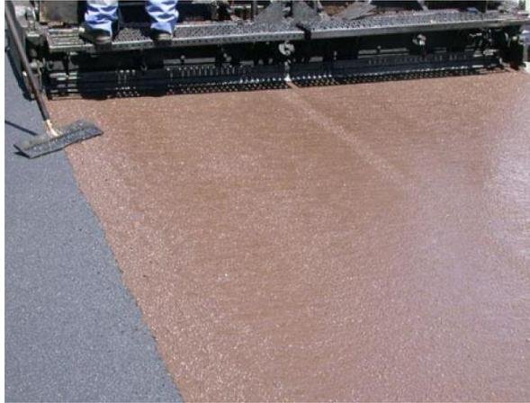
Figure 1-5: ECF fraîchement posé sur la surface de chaussée (SETRA 2005)
