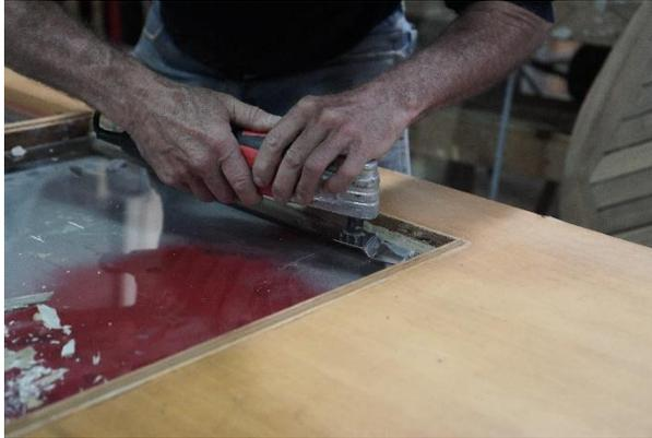
Figure 3.8 Retrait du scellant à l'aide d'une oscilleuse
